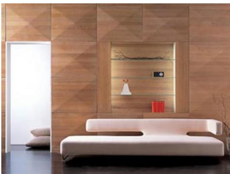
O sistema construtivo das paredes é feito com pranchas com auto-encaixe “macho-fêmea”, no sentido horizontal, com peças pré cortadas, complementadas pelos montantes verticais, não necessitando na montagem do uso de pregos, parafusos ou outros acessórios.
