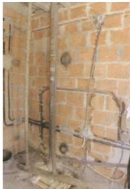
Deverá ser estudada a compatibilização sistemática entre os projectos de arquitectura e das redes de esgotos, de águas e eléctricas, tendo como objectivo garantir uma adequada espessura das paredes para comportarem as diferentes tubagens. Um dos aspectos relevantes a ter em conta, e que foi agravado pelo acréscimo das redes internas, é a possibilidade das mesmas serem perfuradas pelos futuros utilizadores das habitações, decorrentes da sua adequação funcional.
